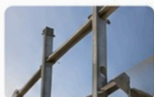
Postes e estruturas metálicas
