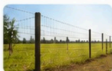
Instalação de mourões e cercas
