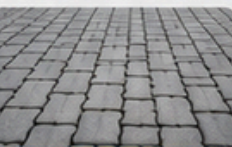
PAVERS E PISOS INTERTRAVADOS
