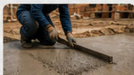
CONCRETO E CONTRAPISO
