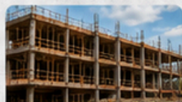
CONSTRUÇÃO CIVIL PEQUENO E MÉDIO PORTE
