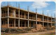
CONSTRUÇÃO CIVIL PEQUENO E MÉDIO PORTE
