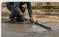
CONCRETO E CONTRAPISO
